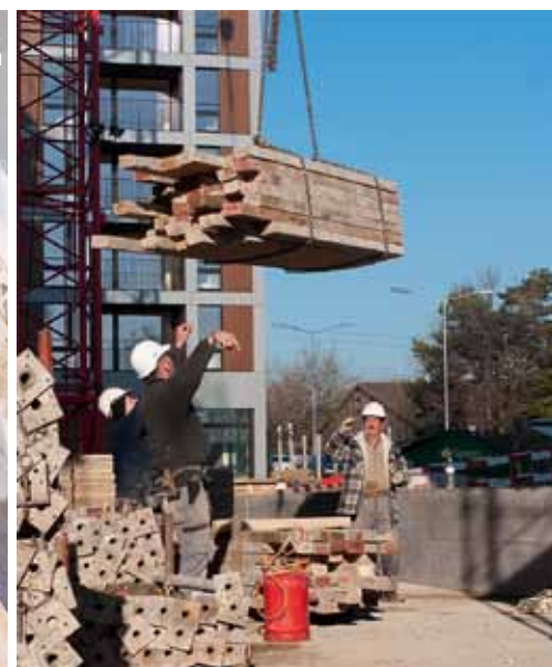
Mit Handzeichen verständigen sich Kranführer und Handwerker auf dem Bau.
